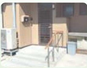
▲玄関アプローチの階段段差の緩和および手すりの取り付け工事
